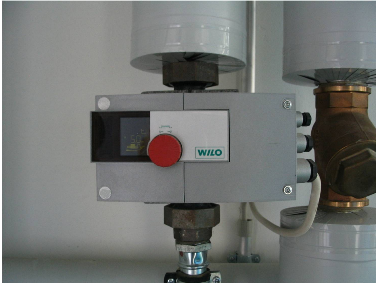
Steinkopfhalle Ockstadt Hocheffizienz-Heizungspumpe 2009
