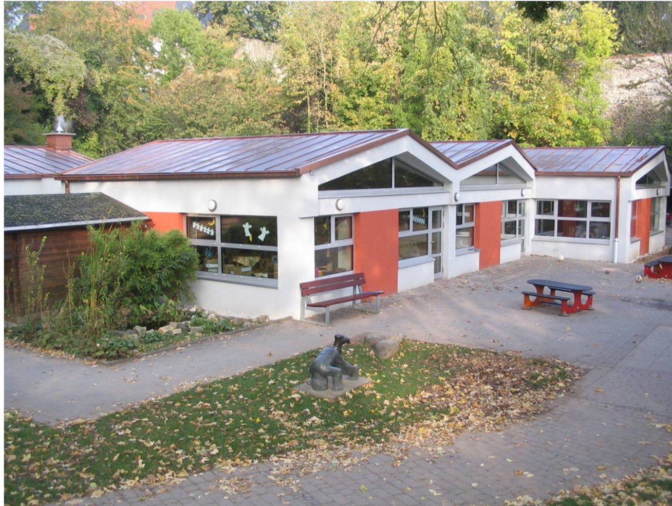
Kita Räuberhöhle Usagasse 40 Ern. Fenster, Dämmung 2010
