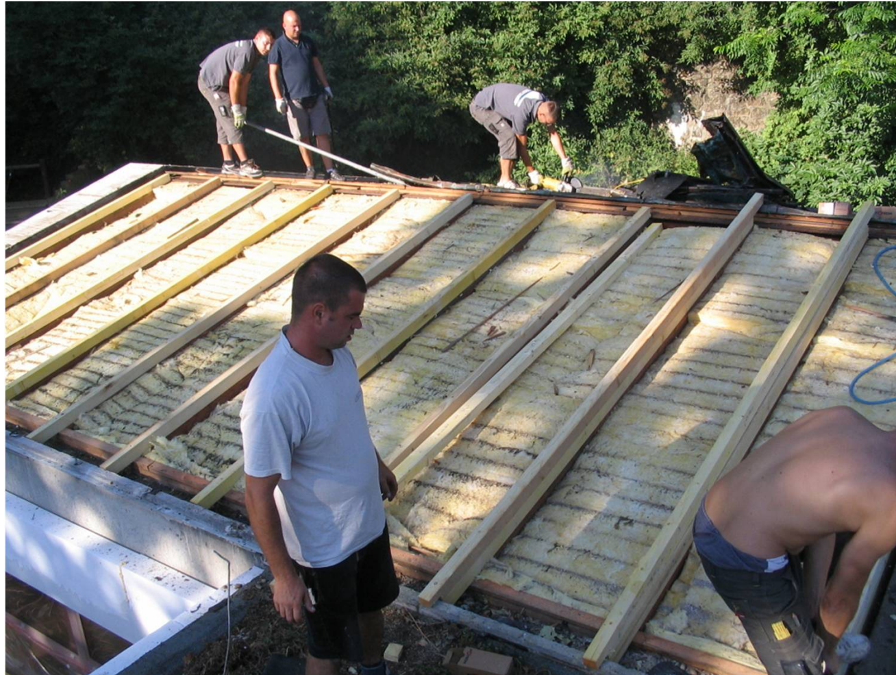
Kita Räuberhöhle Usagasse 40 Dämmung Dach 2010
