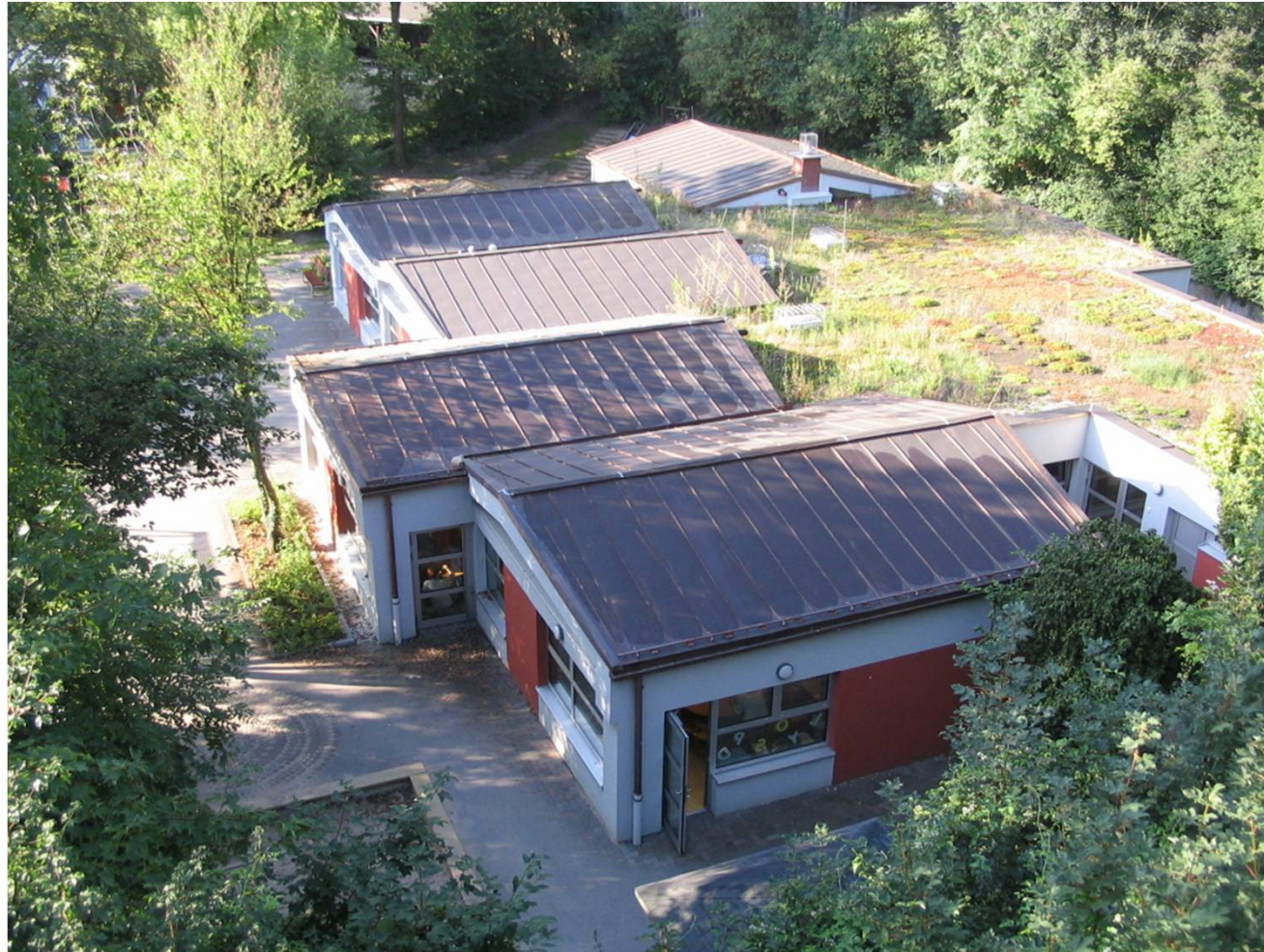
Kita Räuberhöhle Usagasse 40 Ern. Fenster, Dämmung 2010
