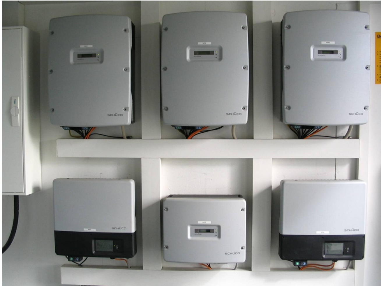
Steinkopfhalle Ockstadt PV-Anlage Wechselrichter 2009
