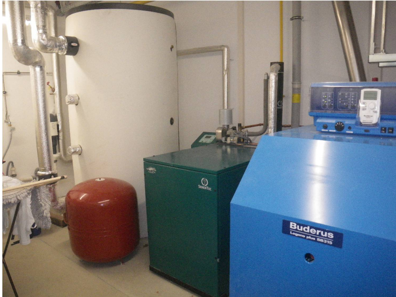
Jugendfreizeiteinrichtung Junity BHKW Kraft-Wärme-Kopplung 2010
