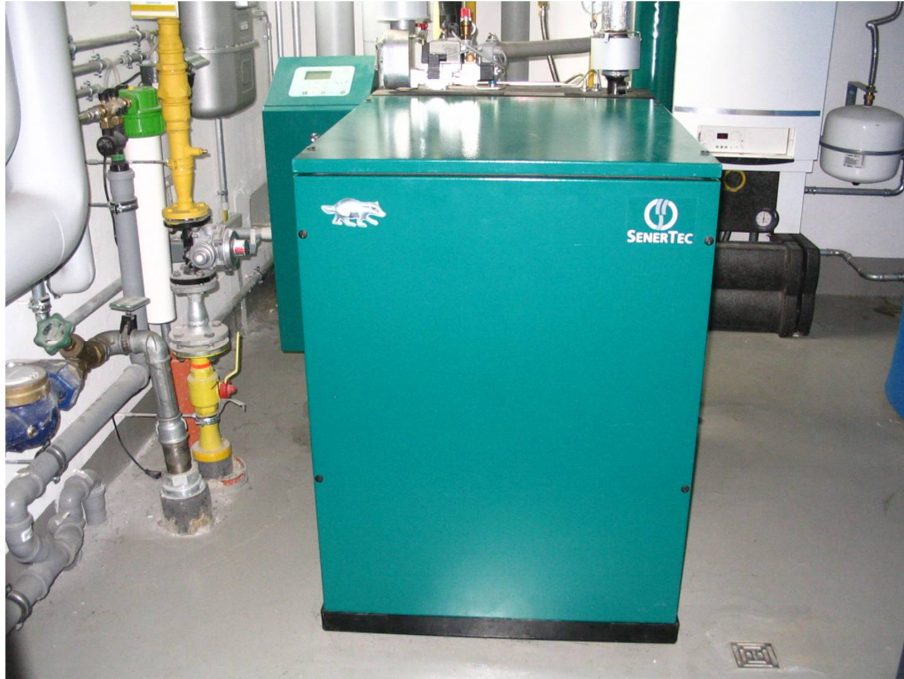
Steinkopfhalle Ockstadt BHKW (Kraft-Wärme-Kopplung) 2009
