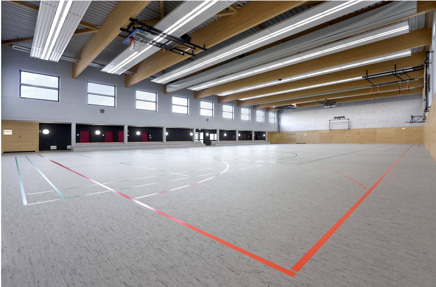
Steinkopfhalle Ockstadt PV-Anlage u. BHKW 2009
