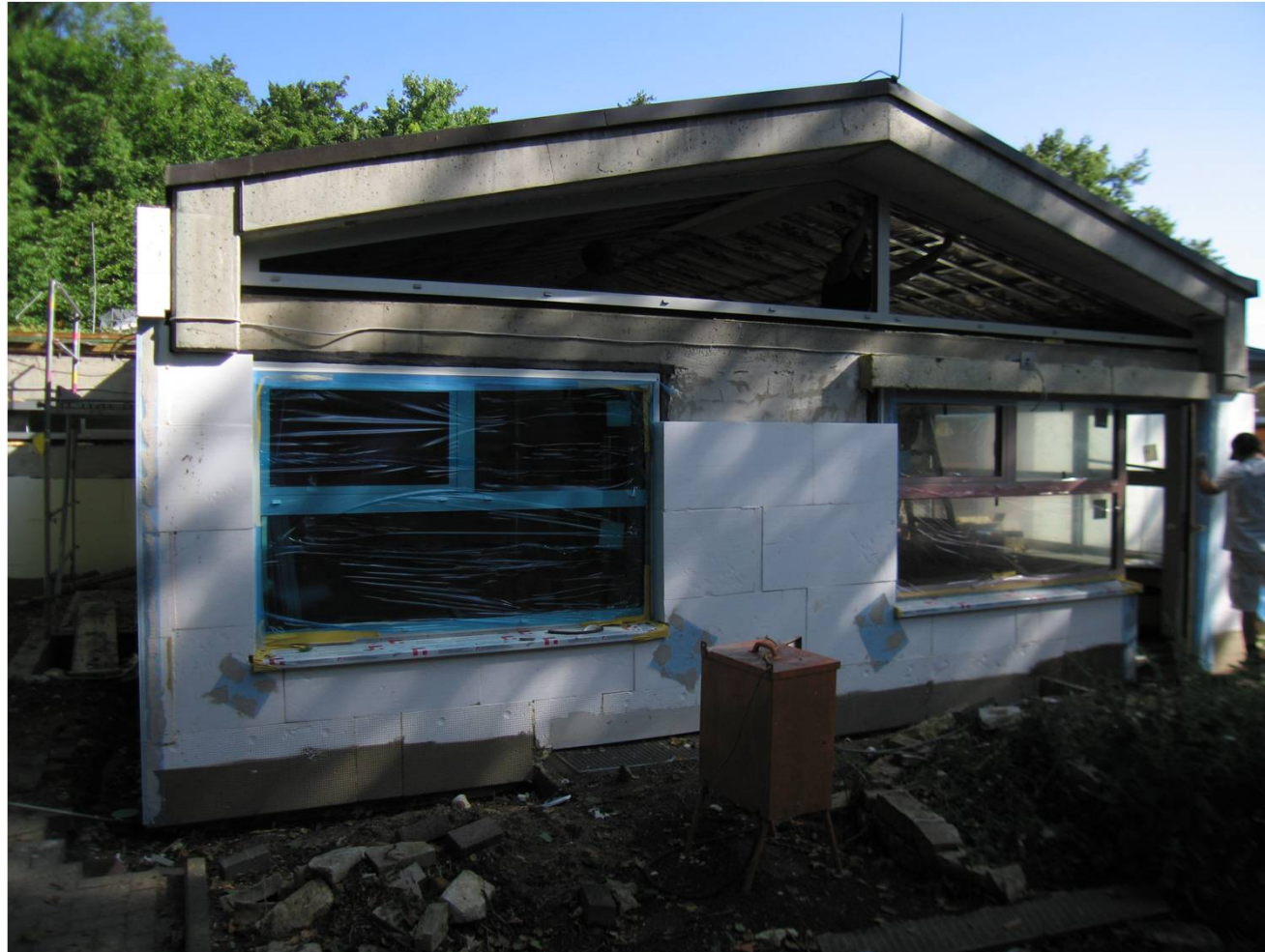
Kita Räuberhöhle Usagasse 40 Ern. Fenster, Dämmung 2010
