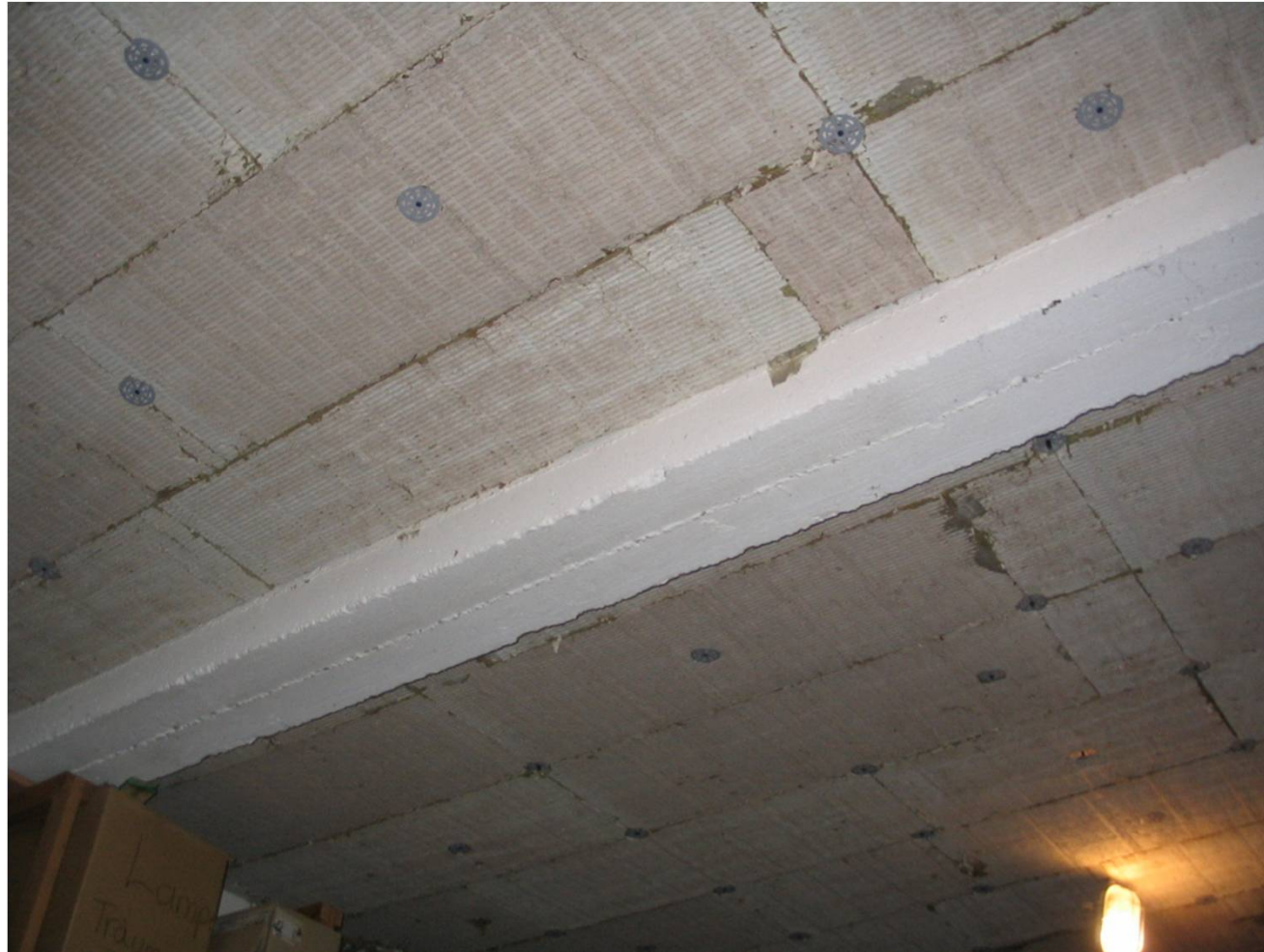
Kita Räuberhöhle Usagasse 40 Dämmung Kellerdecke 2010
