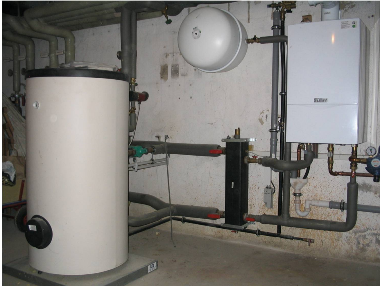
Kita Räuberhöhle Usagasse 40 Erneuerung Heizung 2007
