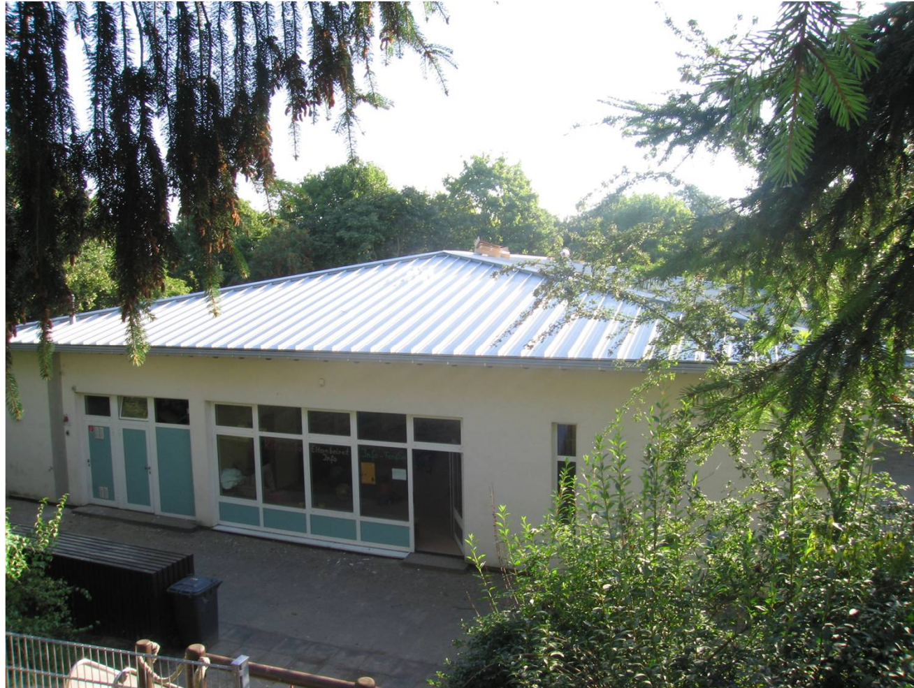
Kita Bruchenbrücken Dachsanierung 2009
