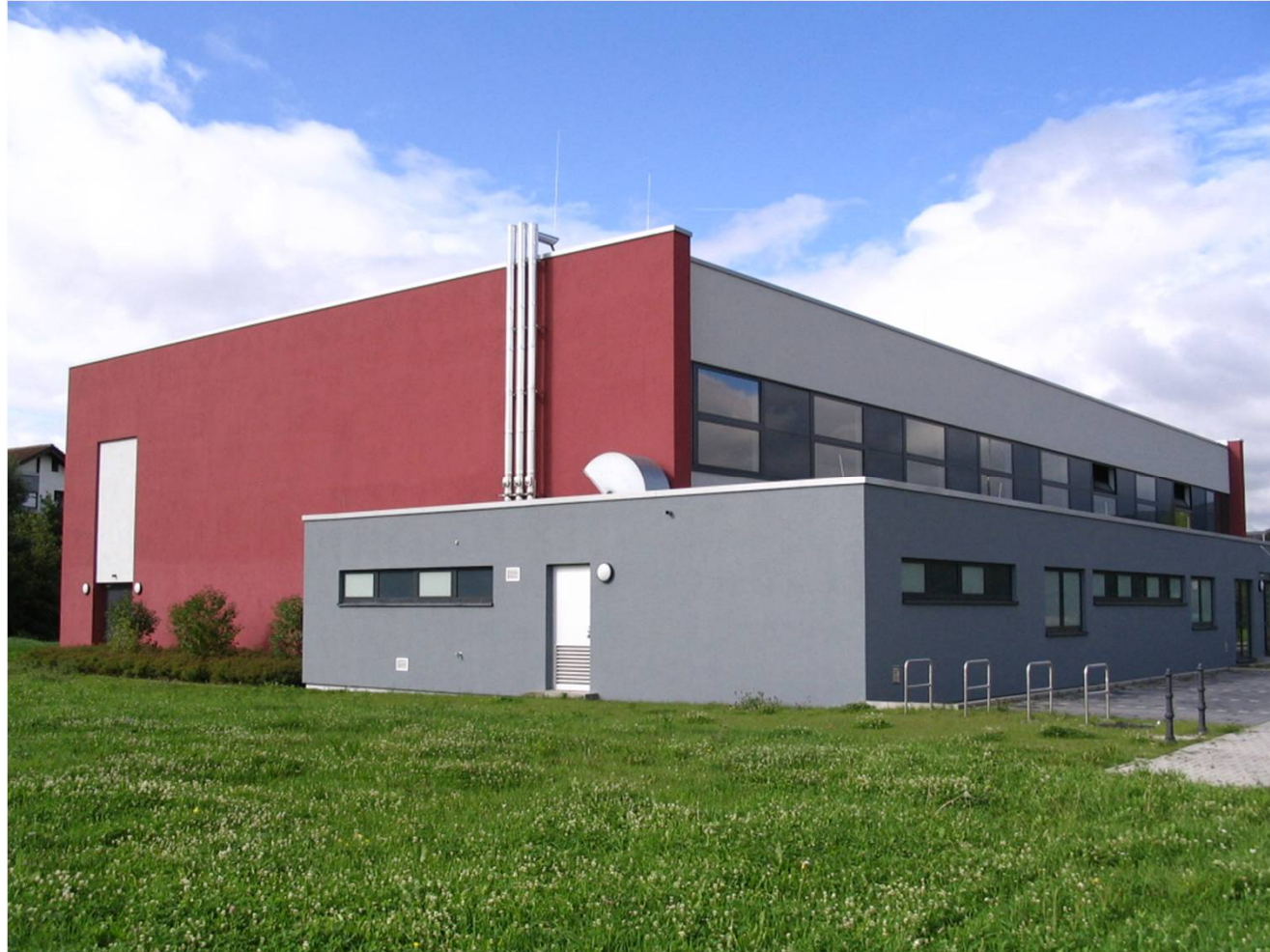
Steinkopfhalle Ockstadt PV-Anlage u. BHKW 2009
