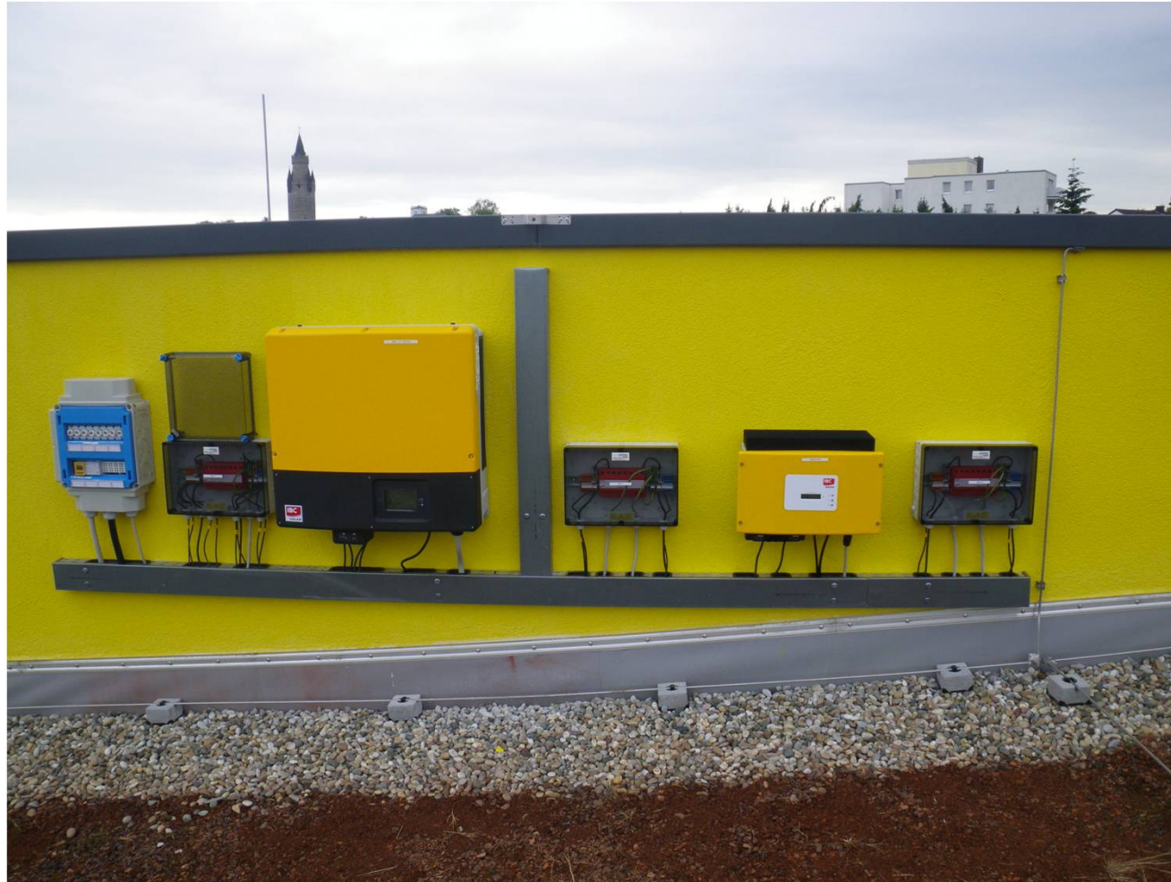
Jugendfreizeiteinrichtung Junity PV-Anlage Wechselrichter 2011
